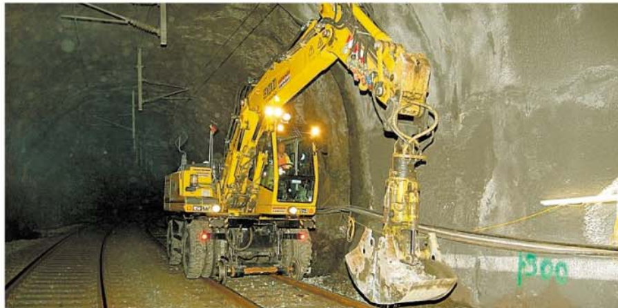
Beim Bau des Brennerbasistunnels fallen Millionen Kubikmeter Aushubmaterial an. Foto: Max
